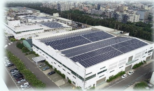
桃園市鋼鐵工廠1.8MW
