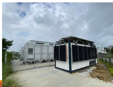
現地勘查儲能系統
