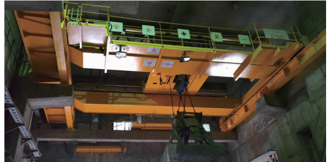
灰爐吊車整修及新設操作室
