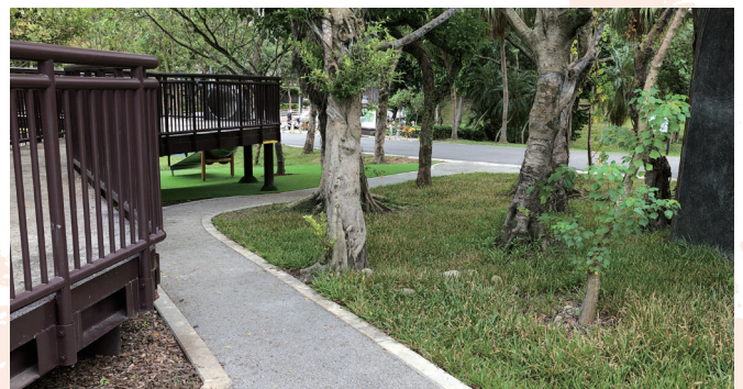
南港公園透水鋪面
